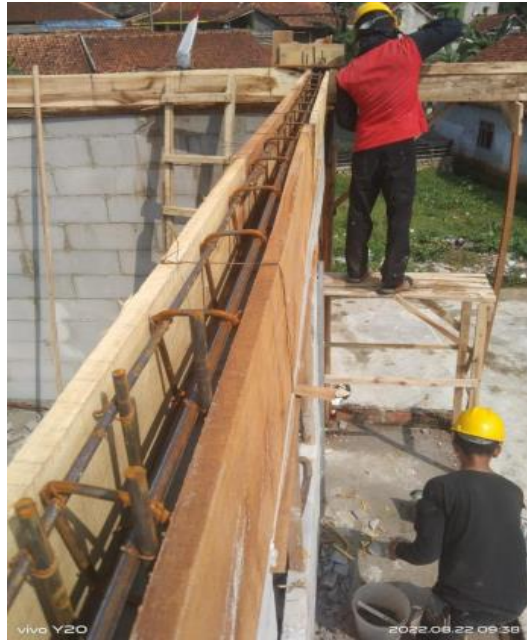
Gambar 5. Pekerjaan Pembuatan Ring Balok
