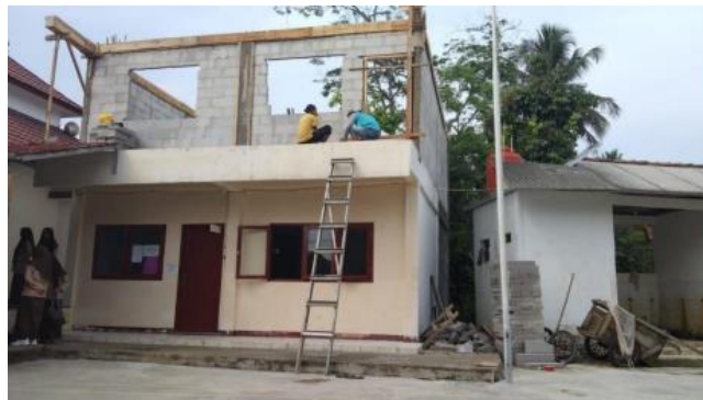
Gambar 6. Pekerjaan Pemasangan Kusen Jendela dan Pintu.
