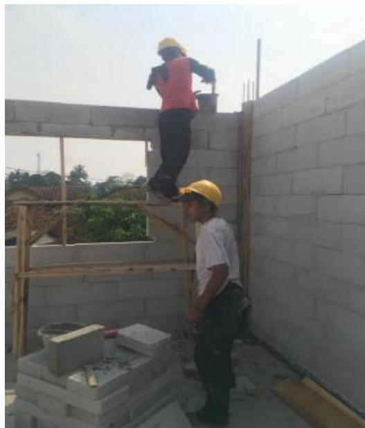
Gambar 4. Pekerjaan Pembuatan Dinding
