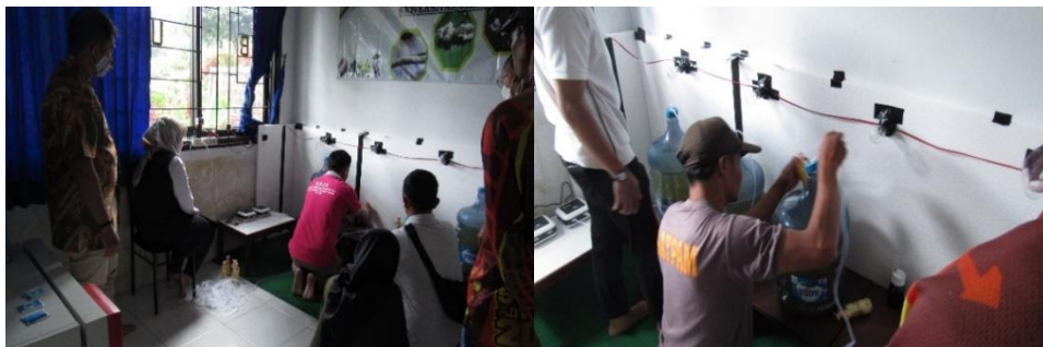
Gambar 3. Instalasi Aerator oleh Tim Pengabdian dilanjutkan oleh Pekerja Binaan
