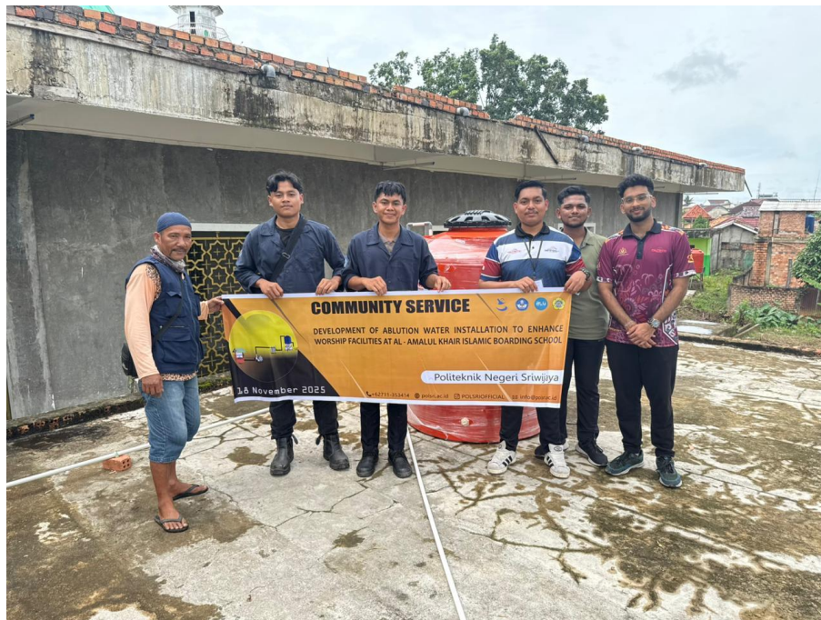
Gambar 4. Pemasangan tangki 1.000 liter
