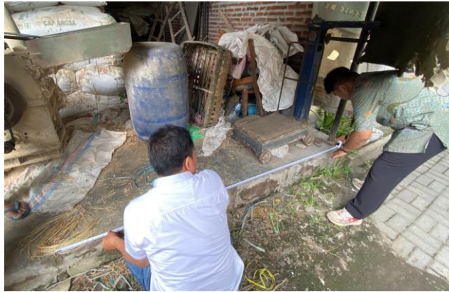
Gambar 5. Tahap Persiapan berupa Survei Lapangan dengan Pengukuran Area Peletakan Timbangan
