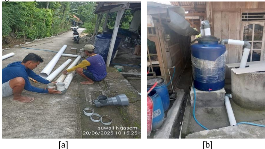
Gambar 2. Proses Pembuatan IPAH (a) dan Instalasi IPAH siap digunakan (b)
