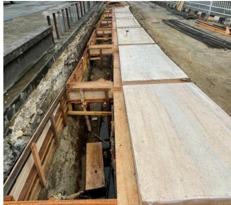
Gambar 8. Pemasangan bekisting
