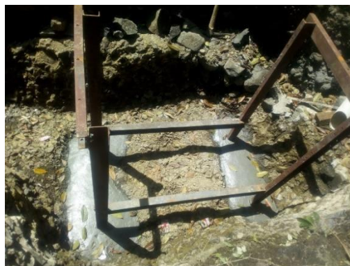
Gambar 7. Konstruksi rangka rumah pembangkit
