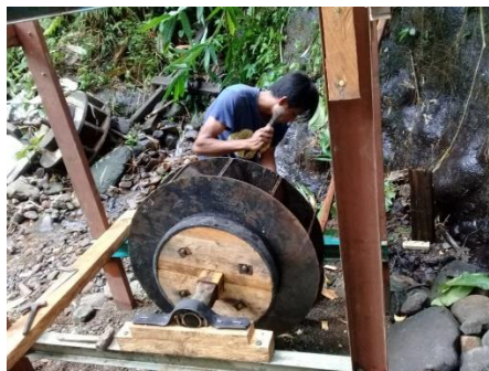
Gambar 8. Pemasangan turbin
