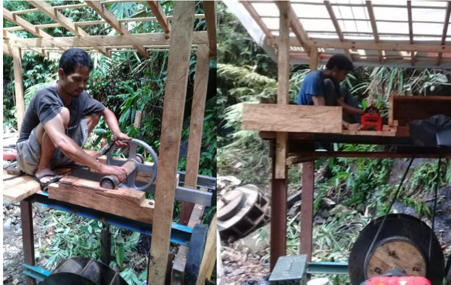
Gambar 9. Setting pulley dan pemasangan turbin-generator di rumah pembangkit
