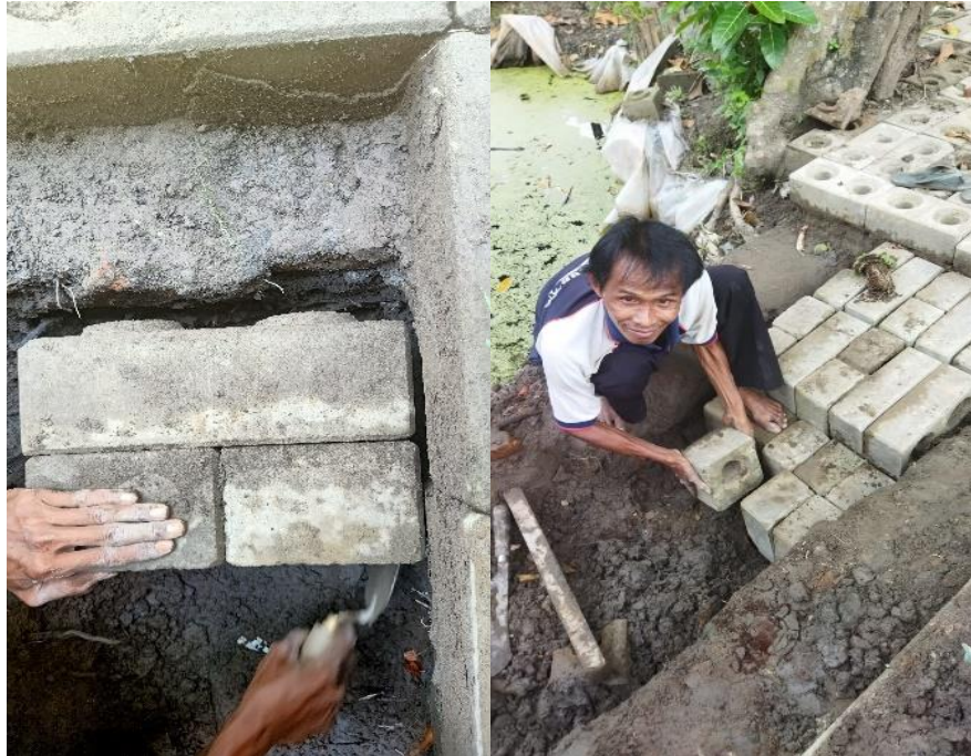
Gambar 6. Penyusunan bata KOBEL untuk mendapatkan alur aliran
