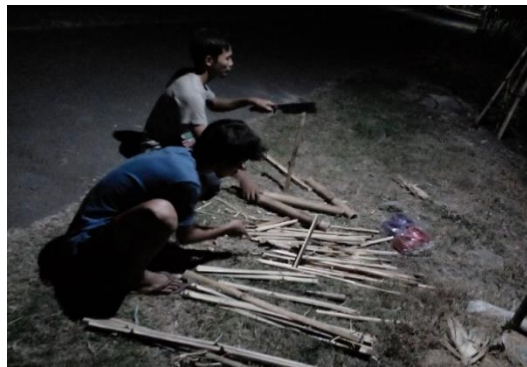
Gambar 4 Penyiapan Penompang Bambu
