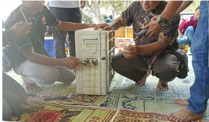
Gambar 3. Praktek mendeteksi kebocoran freon menggunakan leaking detector.
